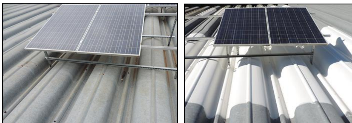
Figura 18 - Montagem dos conjuntos A e B
