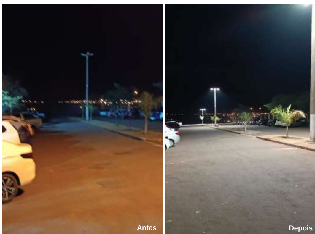
Figura 2 - Troca da iluminação do estacionamento da Unidade Flamboyant
