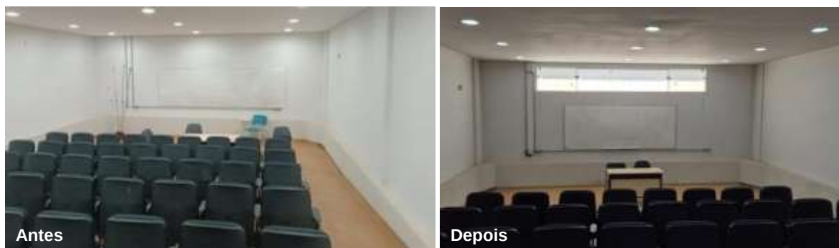
Figura 1 - Instalação de janela nos miniauditórios da Unidade Flamboyant
