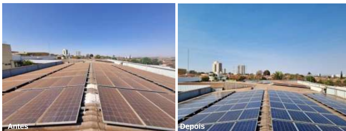
Figura 8 - Limpeza periódica das placas fotovoltaicas
