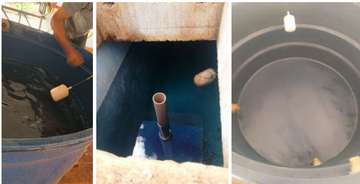
Figura 13 – Limpeza das caixas d'água.
