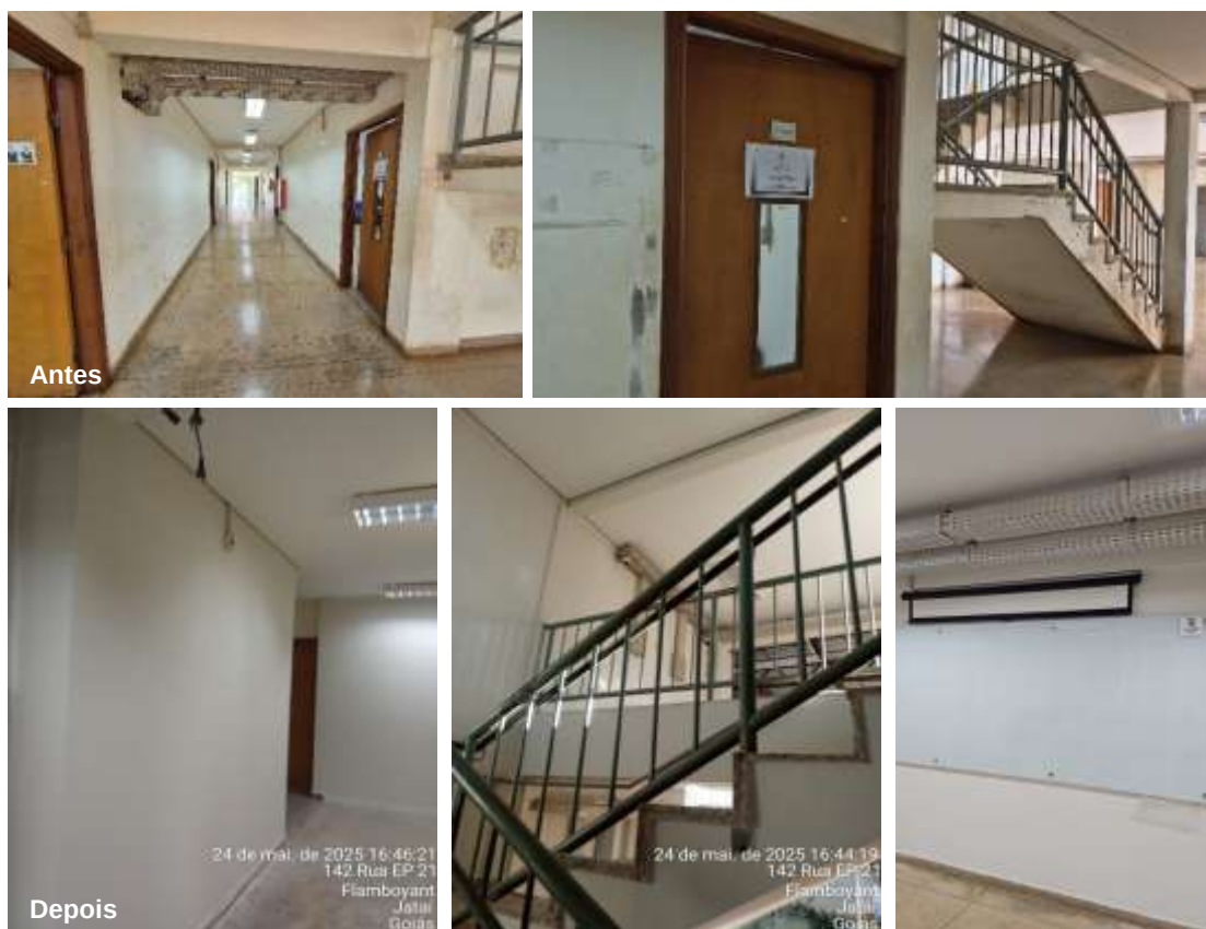
Figura 2 – Reforma e pintura das paredes do Bloco 400.
