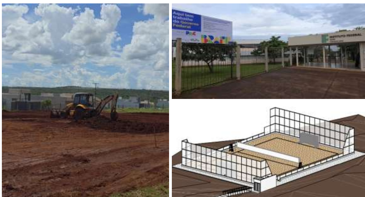
Figura 6 – Início das obras da quadra de areia da Unidade Flamboyant.
