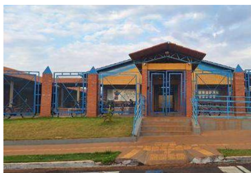
Figura 6 - Colégio Estadual Frei Domingos. Fachada frontal da entrada
